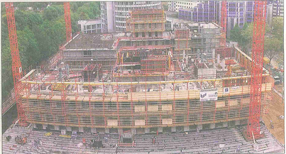
Langsam wächst der Neubau der Deutschen Börse in den Himmel von Eschborn. Das Netzwerk an Kabeln und Elektrotechnik wird in Gaggenau geplant.
